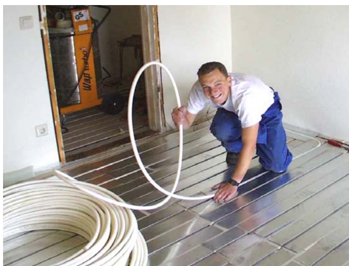
Figur 3.3 Legging av gulvvarmerør i profilerte aluminiumsplater på trefiberplater.
