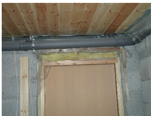
Kuldebro i kjeller i en frittliggende enebolig.
