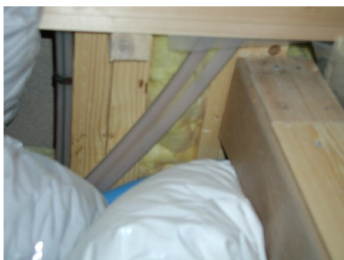
Uisolerte rør i frittliggende enebolig.
