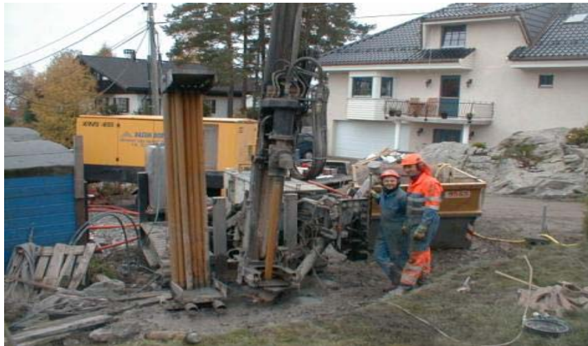
Figur 5.5: Boring av energibrønn til enebolig (SVEP, 2002).
