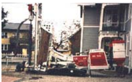
Figur 5.3 (fra Brunnsborrarna, 2002): Her ser vi boreutrustningen til Brunnsborrarna fra Sverige. Heller ikke størrelsen på denne maskinen er spesielt stor.
