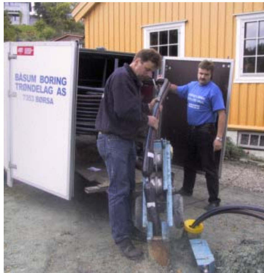
Nedsetting av kollektor
