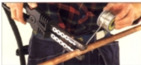
Mjuklödning med elektrisk lödapparat.
