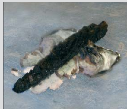
Brannpåvirkning av trekonstruksjon med glassull etter 50 minutter.
