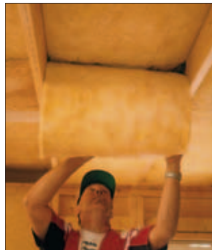
Glava på rull benyttes gjerne også i tak. På bildet vises Glava på rull i etasjeskille- ren. Direkte utrulling av isolasjon i etasjeskille- ren gir rask montering.
