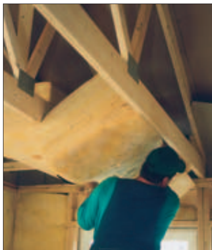
Med Glava Takstolplate monteres isolasjonen i taket i en operasjon. Vekten på en 300 mm Glava Takstolplate er bare 3,5 kg.
