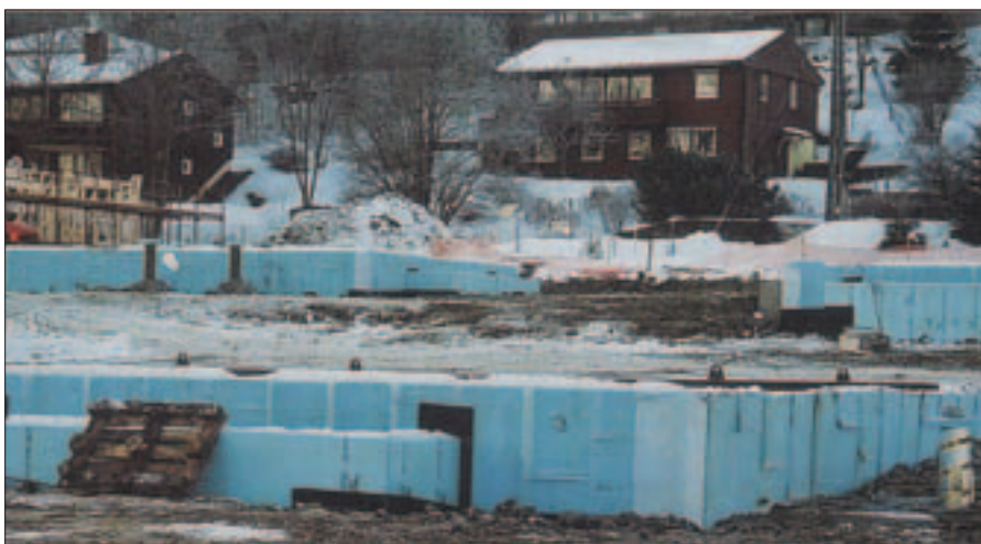
Som isolasjon utenpå mur er kun det beste godt nok. Skadene vises først etter flere år og kostnadene ved utbedring blir uforholdsvismessig dyre. Styrofoam Perimate DI-A opptar minimalt med fuktighet og har særdeles høy trykkstyrke.
