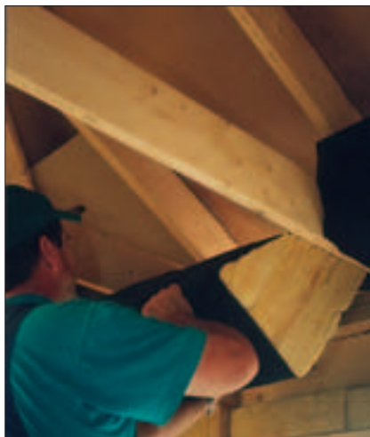
Glava Raftplate er en formskåret glassullplate med impregnert kraftpapir. Benyttes til isolering langs raftene istedenfor tradisjonell rafteskuffe og isolasjon som må tilpasses. Gir rask montering og sikrer luftespalten.
