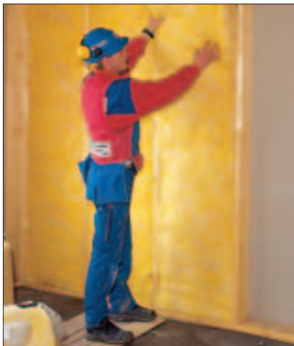
Glava Multi Rull A 37 i 150 mm tykkelse er tilpasset 1 1/2 normal stenderhøyde og monteres uten kapp og spill når det skjæres etter avpassede skjærespor. 1 pakke dekker hele 3 veggfakk.
