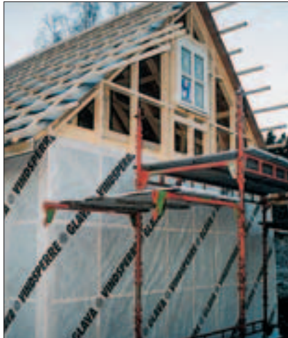
Glava Vindsperre i full etasjehøyde gir et minimum av skjøter og et godt og sikkert resultat. Merk at vindspærren er særdeles transparent som innebærer at stenderen synes. Den transparente vindspærren gir også et svært godt lys inne.
