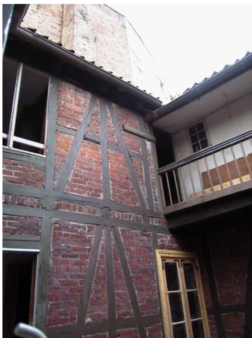
Bakgårdsfasade i utmurt bindingsverk fra midten av 1800-tallet. Oslo
