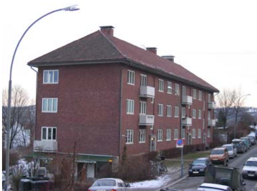
Boligblokk med tradisjonelt valmet saltaksform. Det er her brukt bærende teglvegger og etasjeskillere i betong. Bebyggelsen skiller seg slik ut fra de tradisjonelle murgårdene med etasjeskillere i tre.
