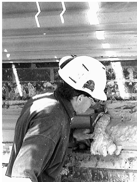
Foto av arbeid med trekninger hvor profilen ovenfor brukes
