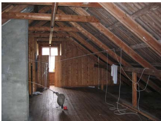
Fotografi fra loft som viser takkonstruksjonen med sperrer med hanebjelker og knebukk
