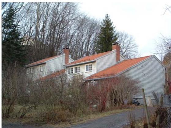
Rekkehus oppført på 1950-tallet i lett bindingsverk med 2 lag utvendig og innvendig panel med papp mellom panellagene, men uten isolasjon i bindingsverkshulrommet
