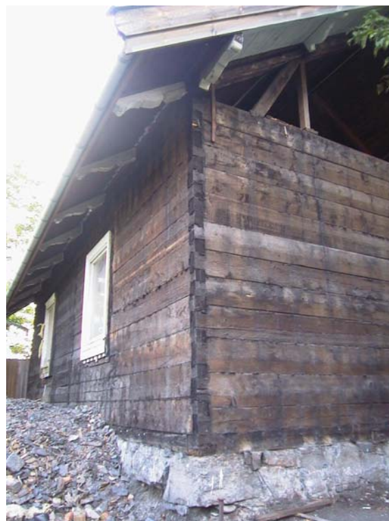
Laftehus fra slutten av 1800-tallet hvor panelet er tatt av.
