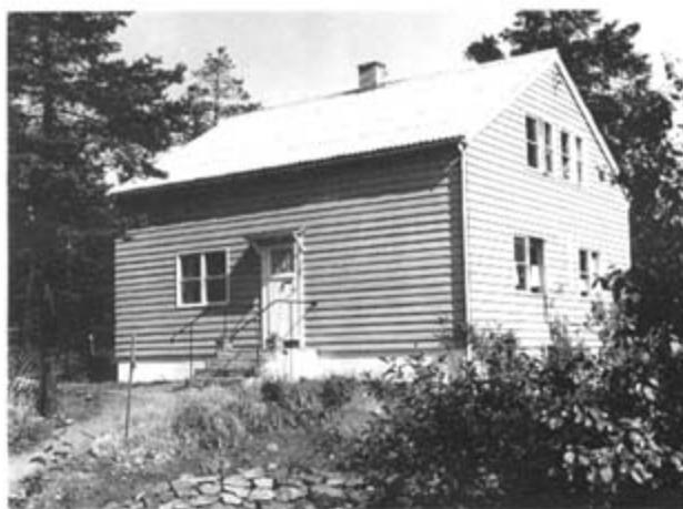
Selvaaghuset – Gjennom radikal forenkling byggeteknisk, bl.a. ved bruk av svært lett bindingsverk, førte denne bygningen og prosessen rundt til radikal forenkling av bygningslovverket
