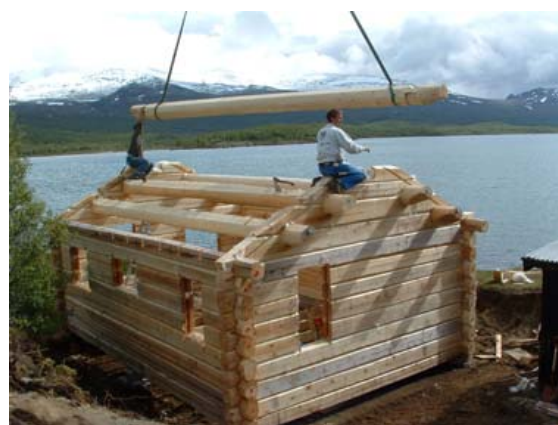
I våre dager er de fleste laftete nybyggene hytter. Laftingen foregår gjerne i større industrihaller og materialene fraktes til tomte og monteres raskt med moderne hjelpemidler. Her sees monteringen av mønsåsen.
