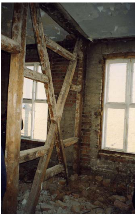
Også i murgårder er det bindingsverksvegger innvendig. Her er en innvendig skillevegg under riving. Dette var en utmurt bindingsverksvegg – teglsteinen er tatt ut.
