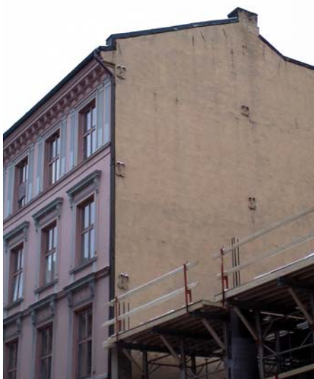
Murgårdsgavl med synlige ankerjernsfester som ligger i etasjeskillehøyde i frontfasaden og i hjerteveggen.
