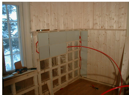
Figur 7.2. Installasjon av kombinert vegg- og gulvvarme i forsøkshus 1. Venstre: Skisse av systemet. Høyre: to bilder fra montering av varmeanlegget med reflekterende aluminiumsfolie, PEX varmerør og aluminium varmedelingsplater.
