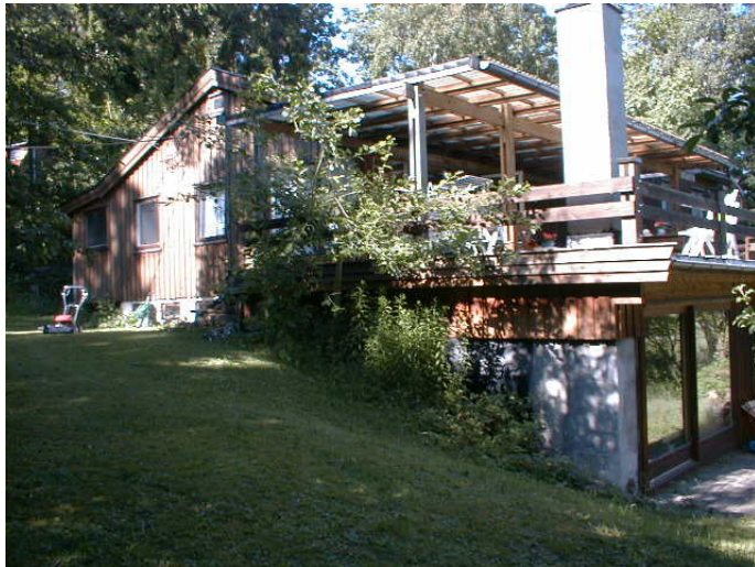
Bilde: Forsøkshus 2 – Enebolig oppført 1967/1968.
