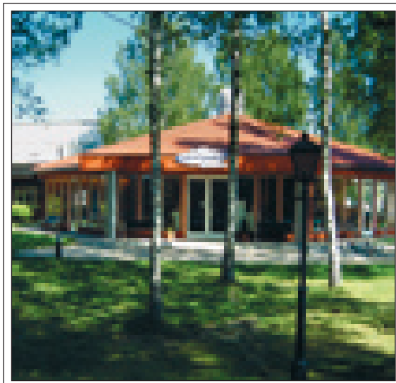
OSO VVSenter med auditorium og laboratorium er "smeltedigelen" for gode ideer og utviklingen av enda bedre beredere.
